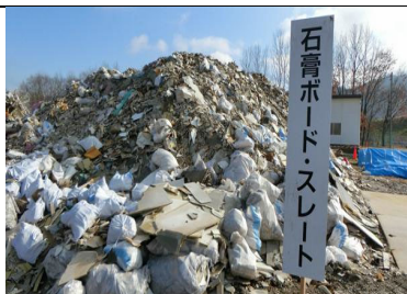
処理困難物 (石膏ボード等)
