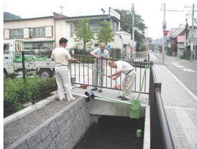
発電機取り付け作業
